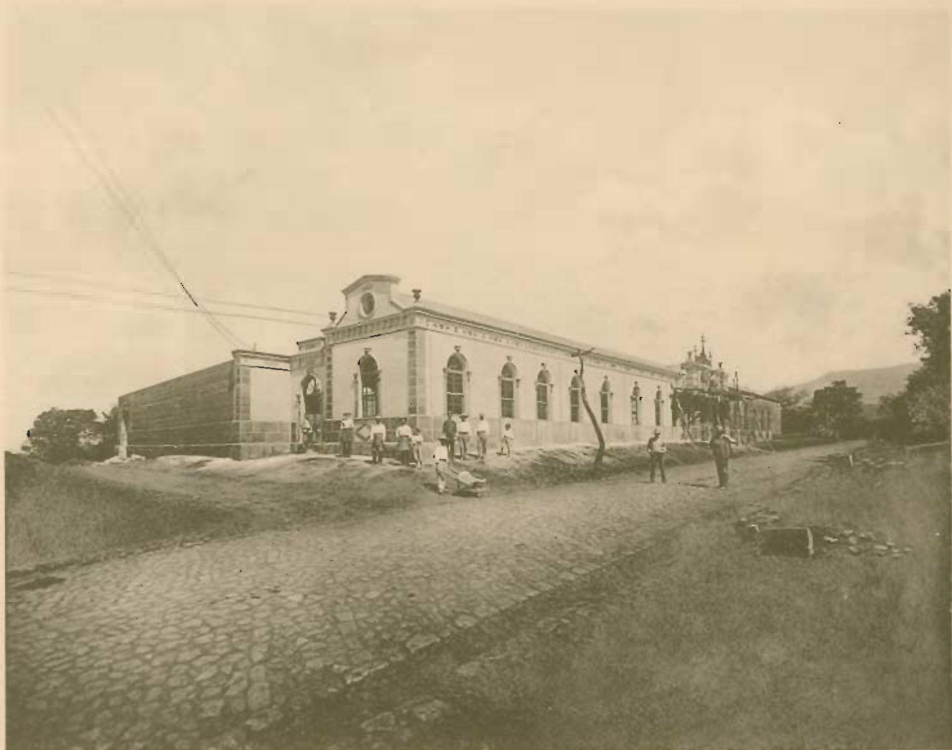
71. Cárcel en construcción. Heredia. — Jail in construction. Heredia.
