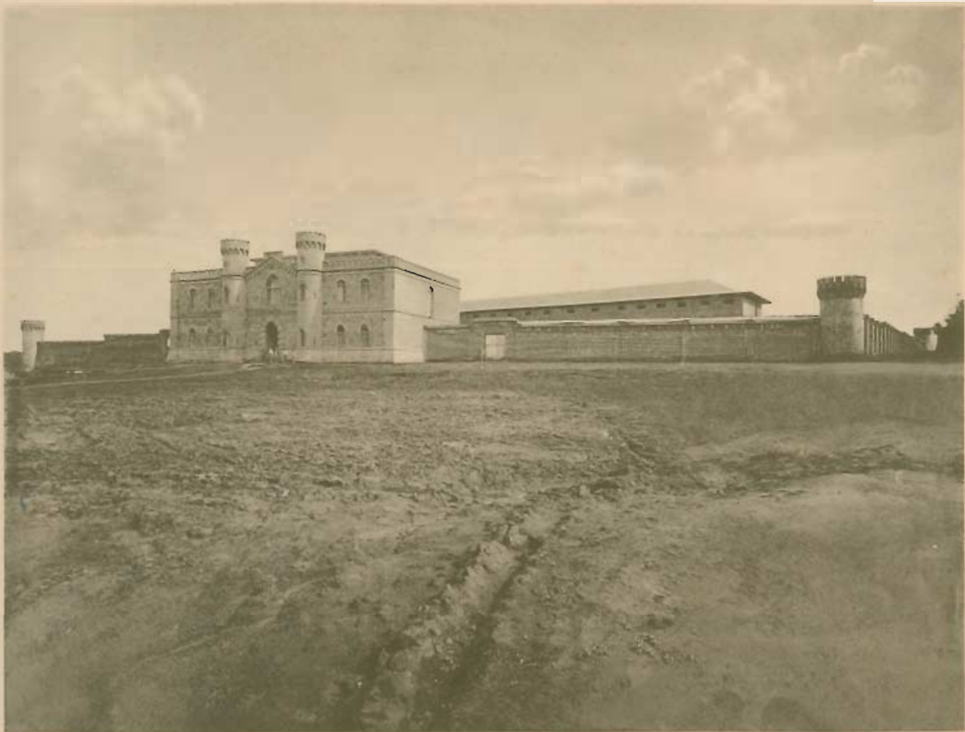
43. Cárcel pública en construcción. San José. — Prison in construction. San José.
